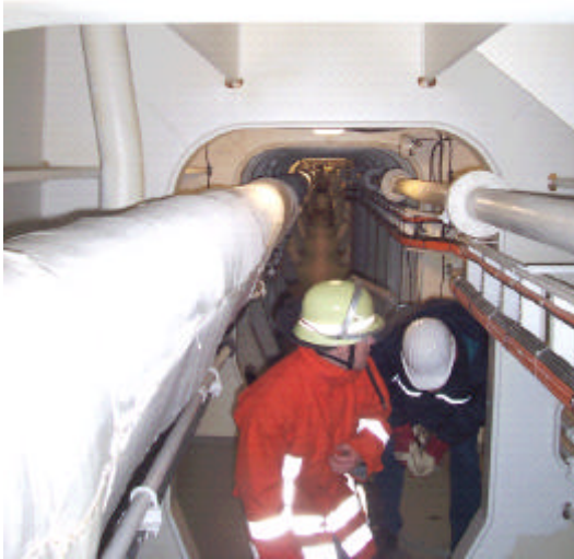
Zugang zu den Laderäumen unter Deck
